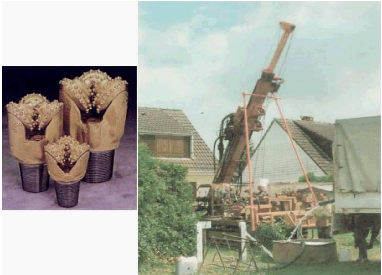
Figure 14 : Sondages destructifs (source E. Manier)
