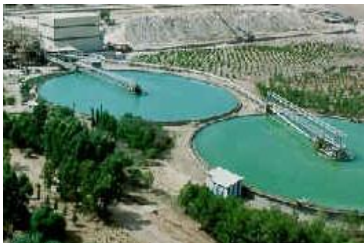
Figure 6: Décanteur D1 et D2.
