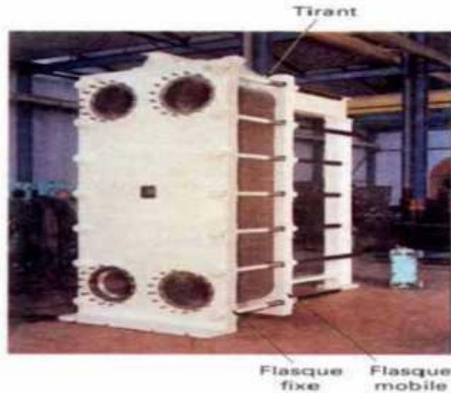
*Échangeur à plaque et joint [3]*
