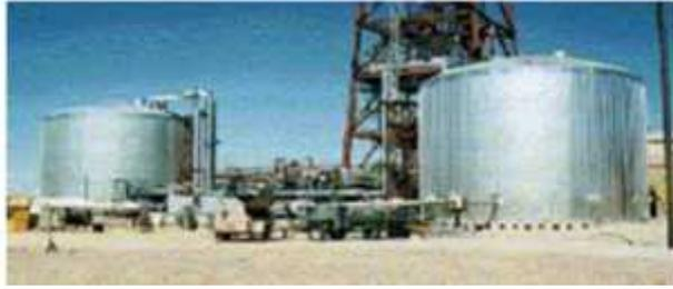
Figure 1-4 Deux cuves de sels fondus se trouvant à la centrale Solar 2 en Californie (USA)[1]
