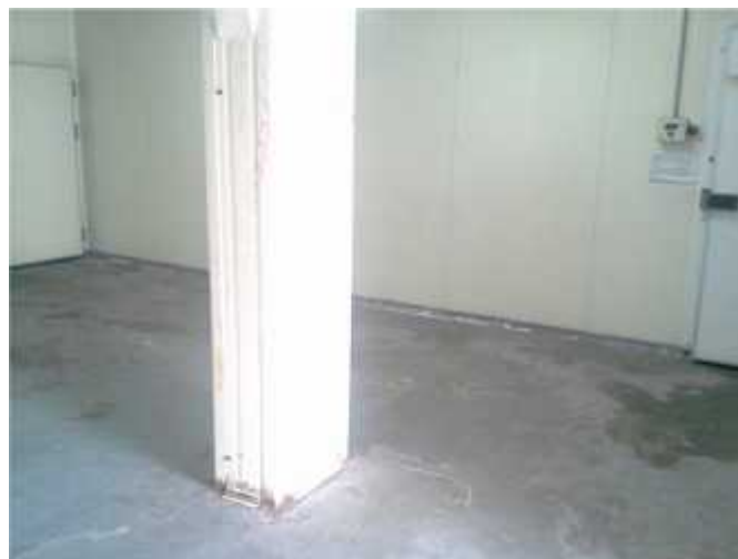
Figure n°54 : l'état de la zone de conditionnement après le nettoyage
