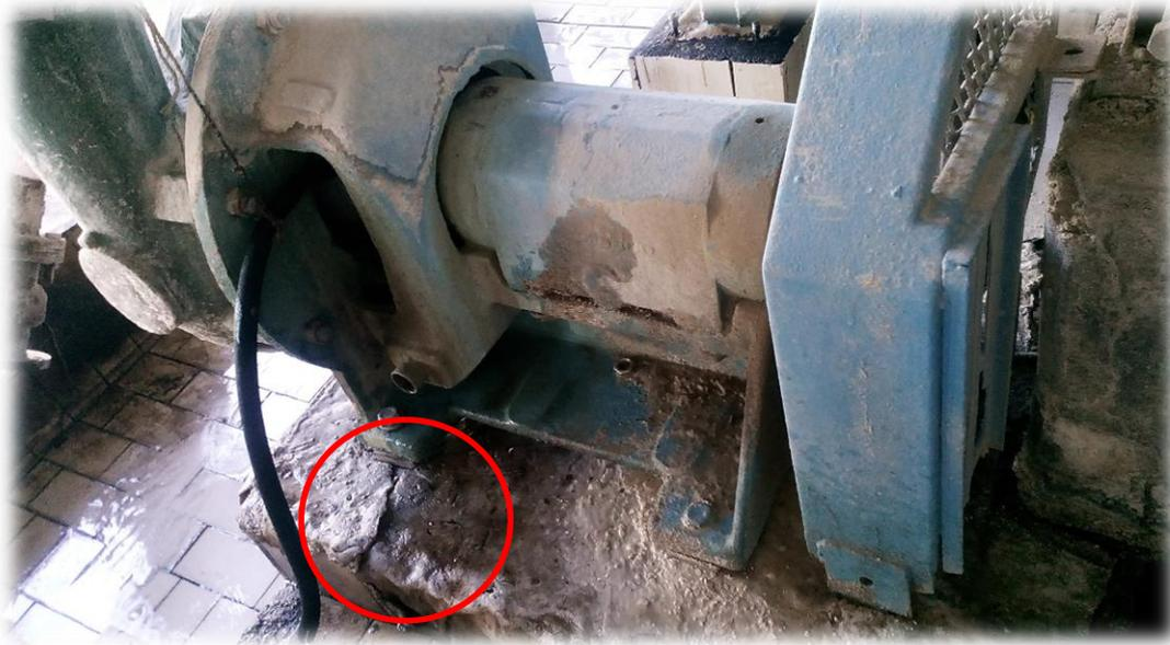
**Figure 17 :** Dégradation des fondations
