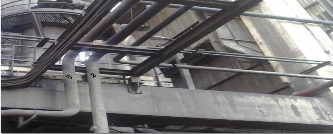
Figure 28 : Les trois conduites du transport d'air comprimé
