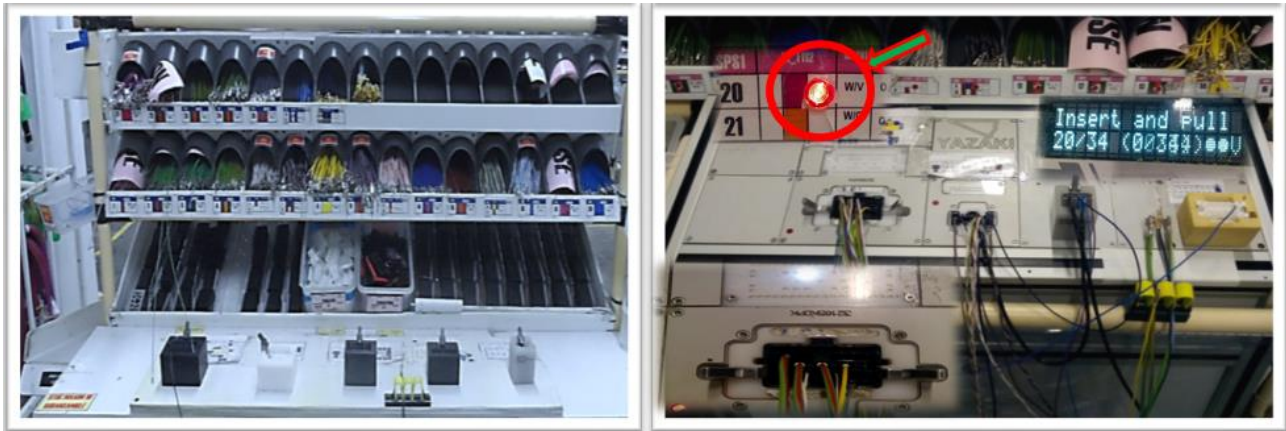
Figure 4.14 : le test électrique qui assure la bonne position des fils dans les cavités des connecteurs
