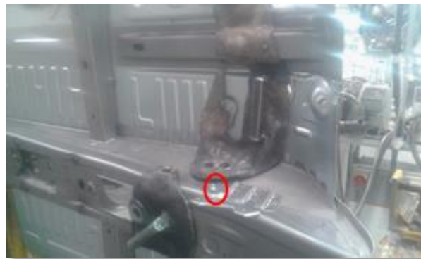
Figure 54: emplacement goujon de masse dans l'unité centrale
