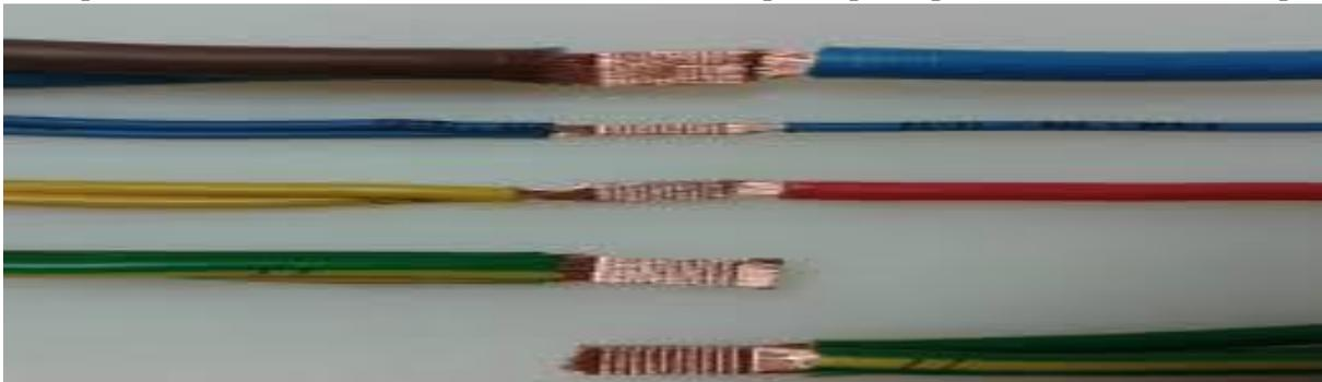
L'épissure doit être protégée par la suite grâce à la housse (Funda) qui doit être placée à l'endroit exacte de l'épissure et chauffée à une température de 500°C à l'aide de la machine Raychem pour couvrir les filaments et assurer leur étanchéité.
