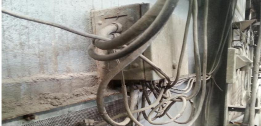
Figure 18 : boîtier électrique du ventilateur d'air
