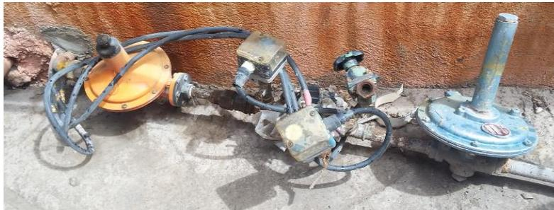
Figure 15 : Electrovanne avec détendeur
