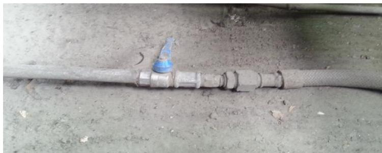
Figure 17 : Conduite équipée de vanne manuelle
