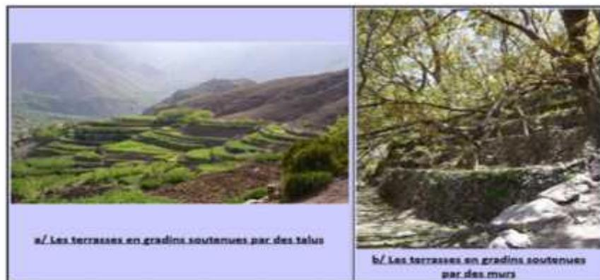
*Figure 5 : Une vue de versants aménagés par des terrasses soutenues par a/ des talus et par b/ des murs en pierre. (Extrait de Arouzoud H.1994)*
