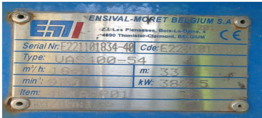
Figure 23: fiche signalétique de la pompe 401AAP01
