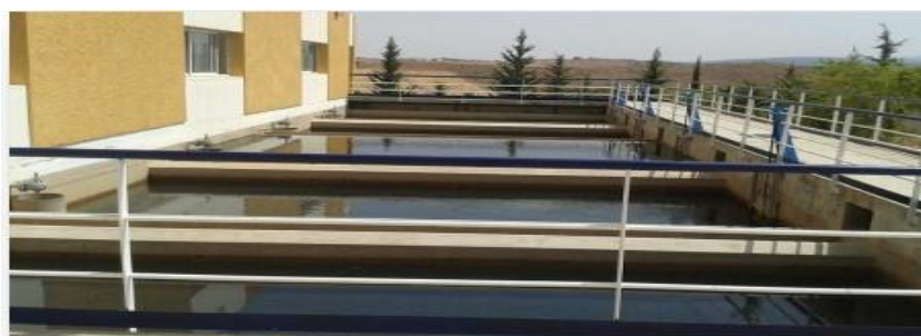
Figure 6 : image du bassin de filtration
