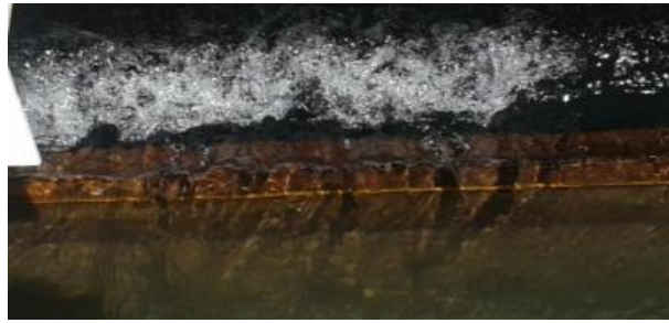
Figure 3: image du bassin d'aération en cascade
