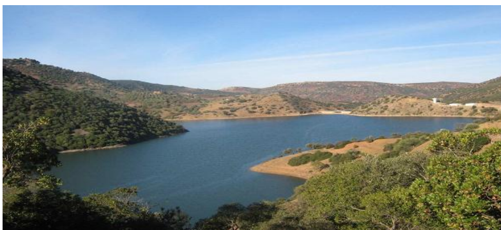
Figure 1 : image du barrage de BAB LOUTA
