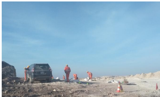
Photo 10 : Remplissage des puits par l'Ammonix précédant le tir
