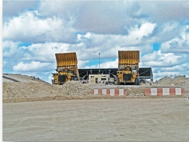
Photo 24 : Le versement du phosphate dans les trémies par les KOMATSU
