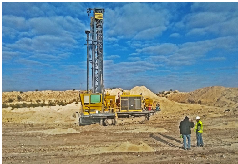
Photo 9 : Sondeuse en cours de foration
