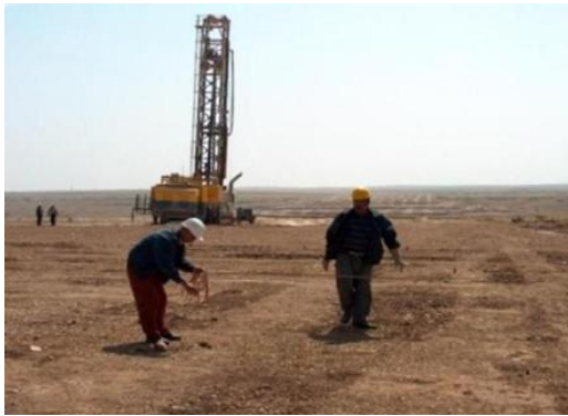
Photo 5 : Implantation des limites par les géomètres
