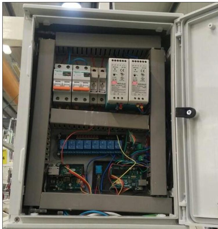
Figure 45: Mise en place du premier test du système d'alarme.
