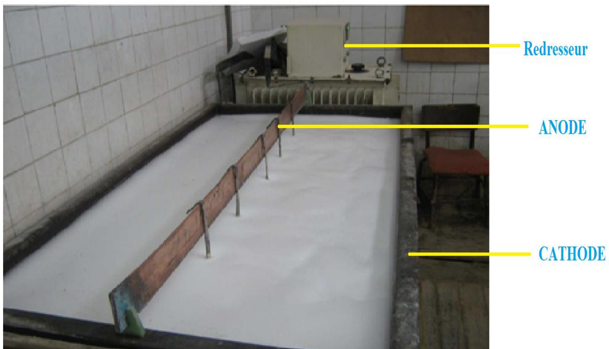
Image 12 : Bain de dégraissage
