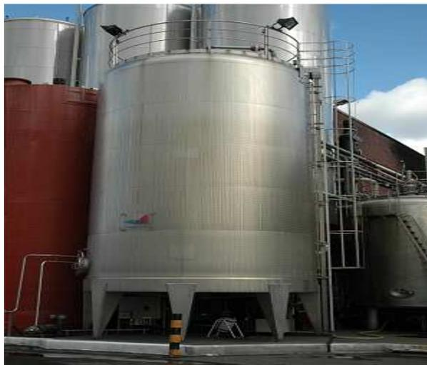
**Figure 6 : fermenteurs utilisés dans la fabrication de la levure de boulanger**
