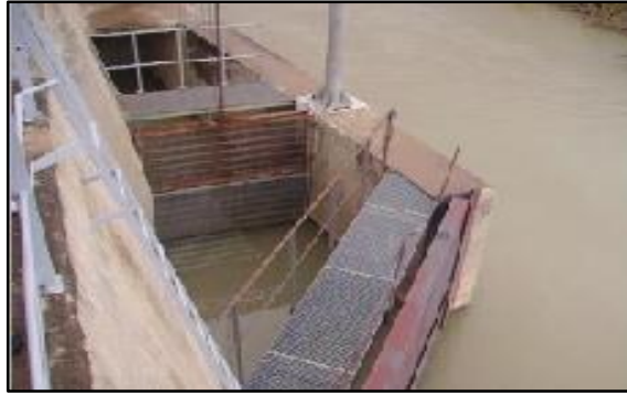
Figure2 : Dégrilleur
