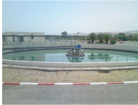
Figure 4: Décanteur
