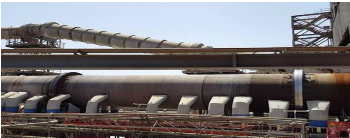
Figure 5 : Four rotatif de Holcim Fès Ras El Ma
