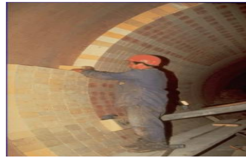
Figure 7 : Installation des briques réfractaire
