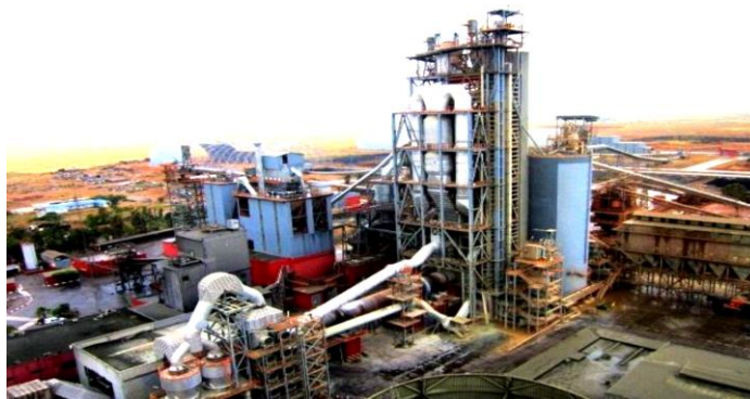
Figure 5 : Cimenterie de Fès-Ras El Ma
