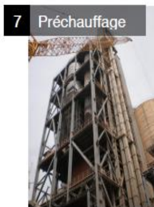
Figure 11 : Tour de préchauffage a cinq étages de cyclones
