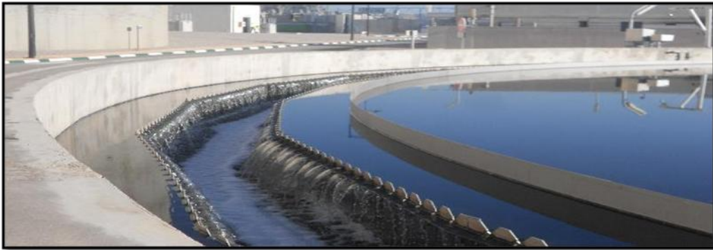
Figure 8: Photos d'un clarificateur STEP Fès
