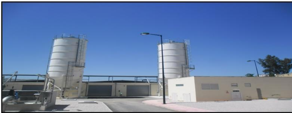
Figure 12: Silos de la chaux STEP Fès
