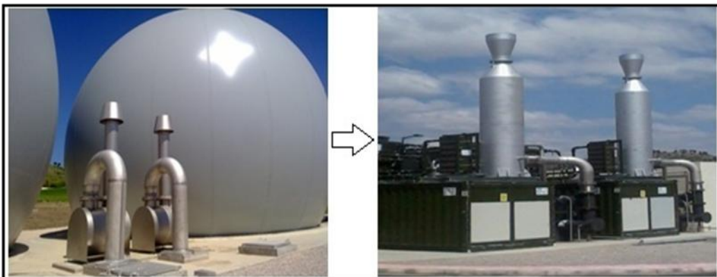
Figure 15: Gaz stocker dans les gazomètres vers l'unité de cogénération STEP Fès
