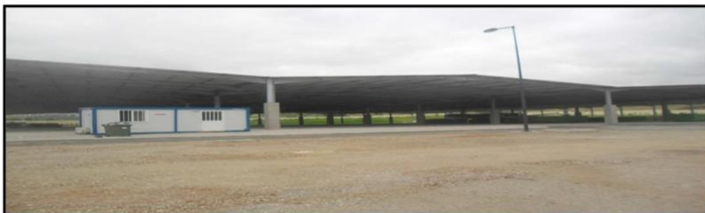
Figure 13: Photo d'un Hall de stockage STEP Fès
