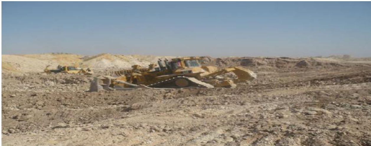
Photo 7: opération de Décapage. Décapage par poussage (bulldozer D11)
