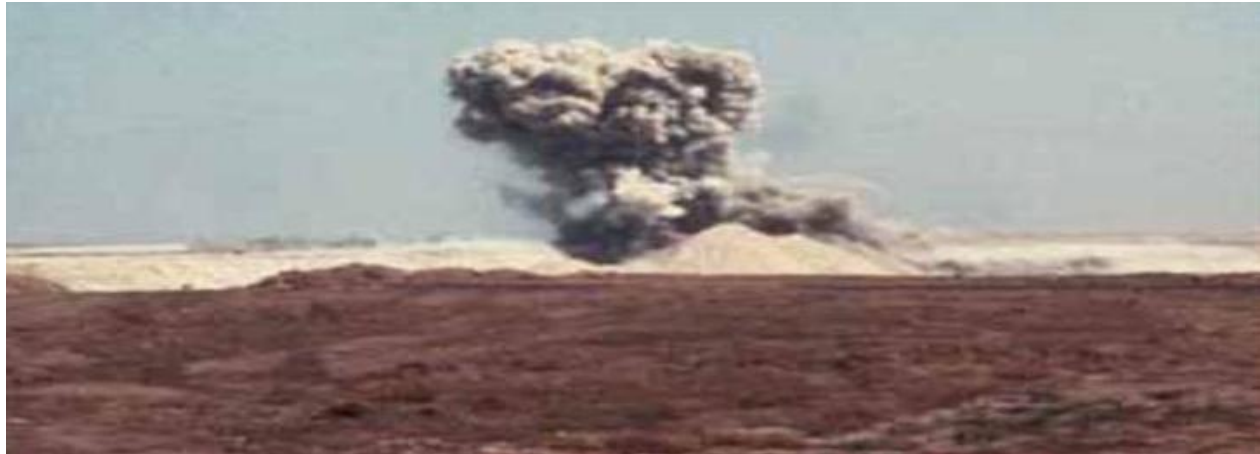
Photo 6 : opération de sautage.
