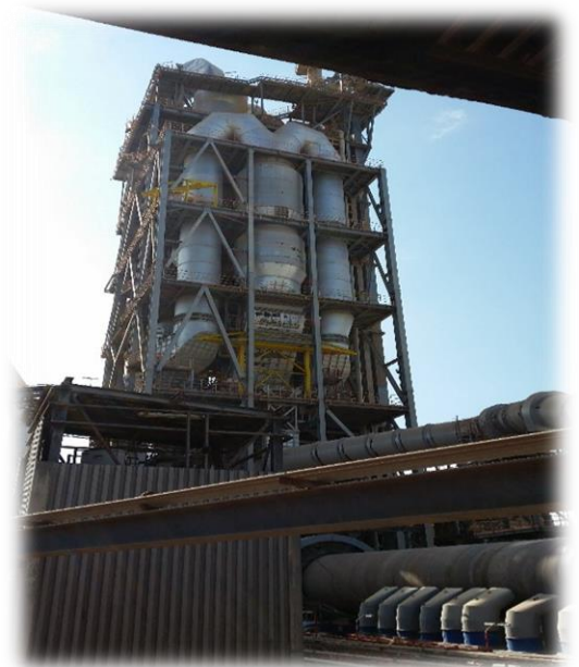
Figure 6: Tour de préchauffage
