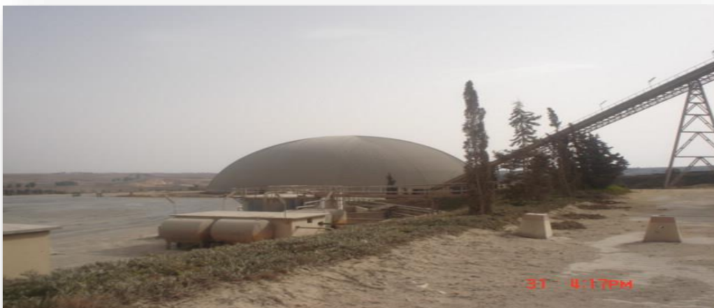
Figure 5:Stockage et préhomogénéisation
