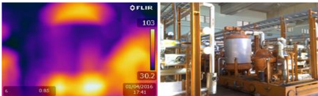
Figure 44: Résultats du prélèvement par le thermographe des mélangeurs.
