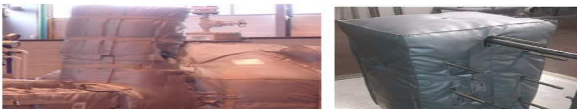
Figure 47: Exemple de calorifugeage de matelas isolent
