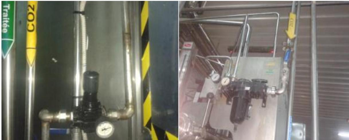
*Figure 20 : Détendeurs de la soutireuse et de mixeur*
