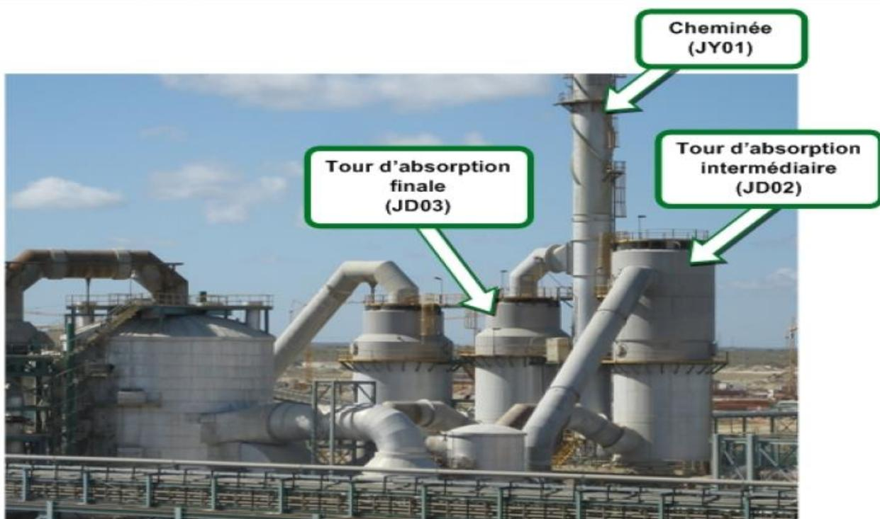
**Figure 13:** Les tours d'absorption intermédiaire finale et de séchage [2]
