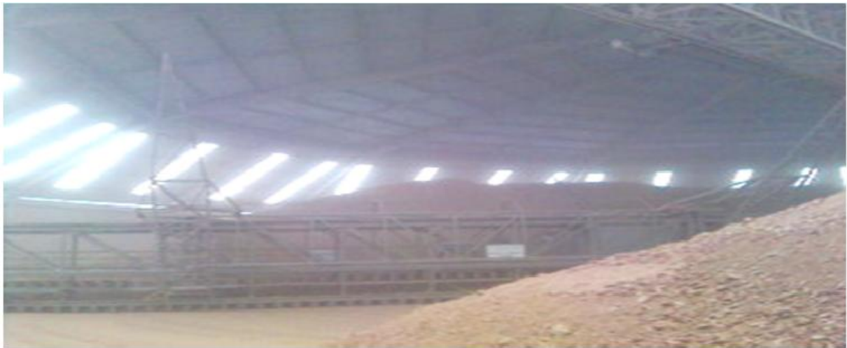
Figure 9 : hall de pré-homogénéisation
