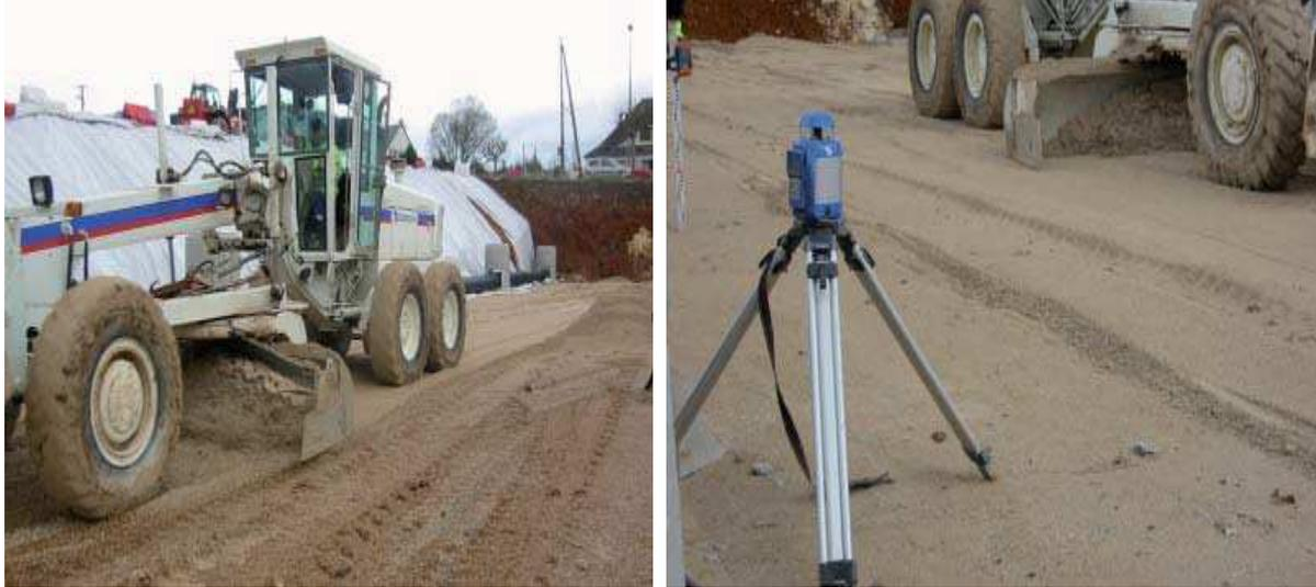
Photo 5. Nivellement du fond de la fouille [5]
