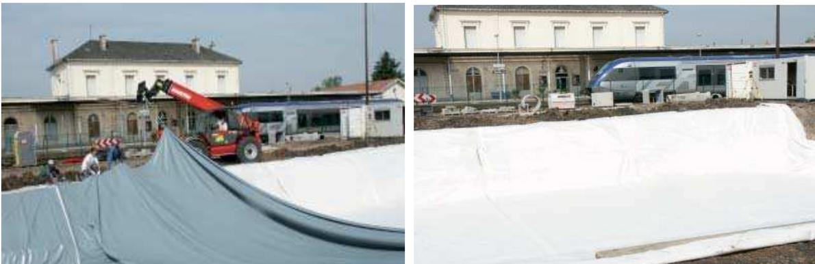
Photo 6. Réalisation de l'étanchéité du bassin de rétention [5]
