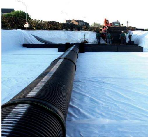
Photo 7. Installation du drain de diffusion[5]
