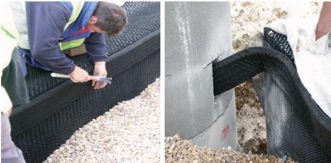
Photo 8. Installation de la couche de ventilation[5]
