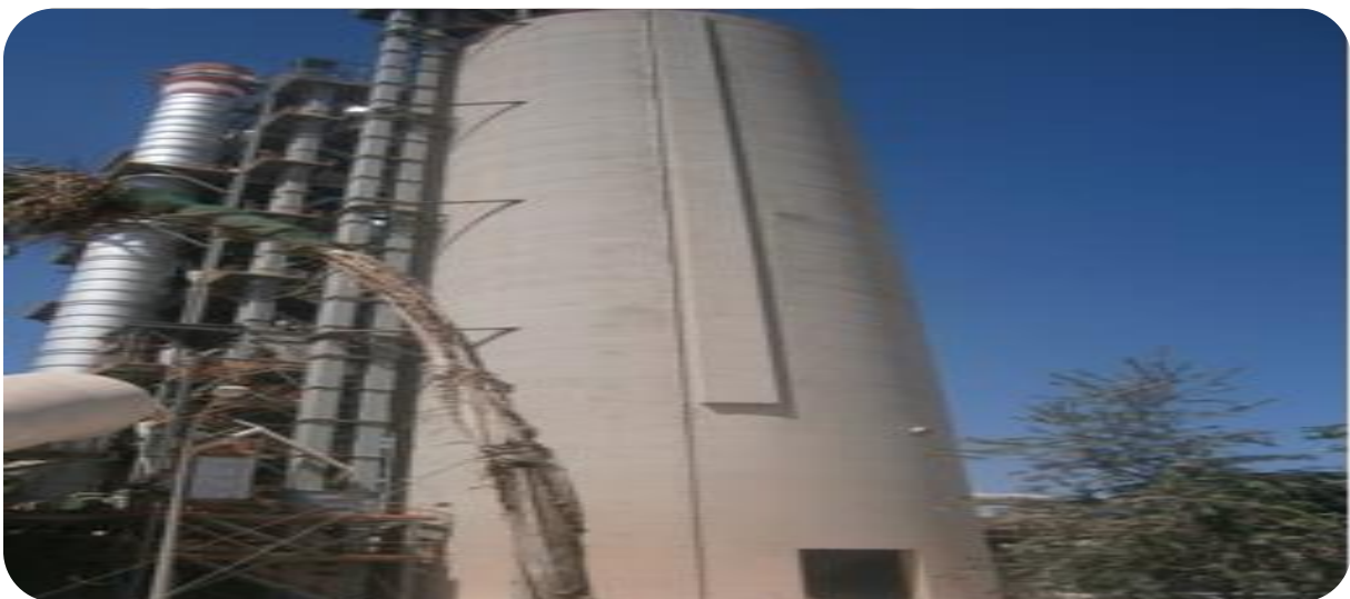
Figure 4 : silo de pré-homogénéisation
