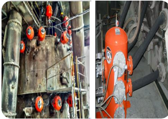
Figure 31 : Position des Airhocs sur un cyclone
