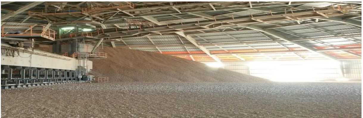
Figure 2 :Parc de pré-homogénéisation
