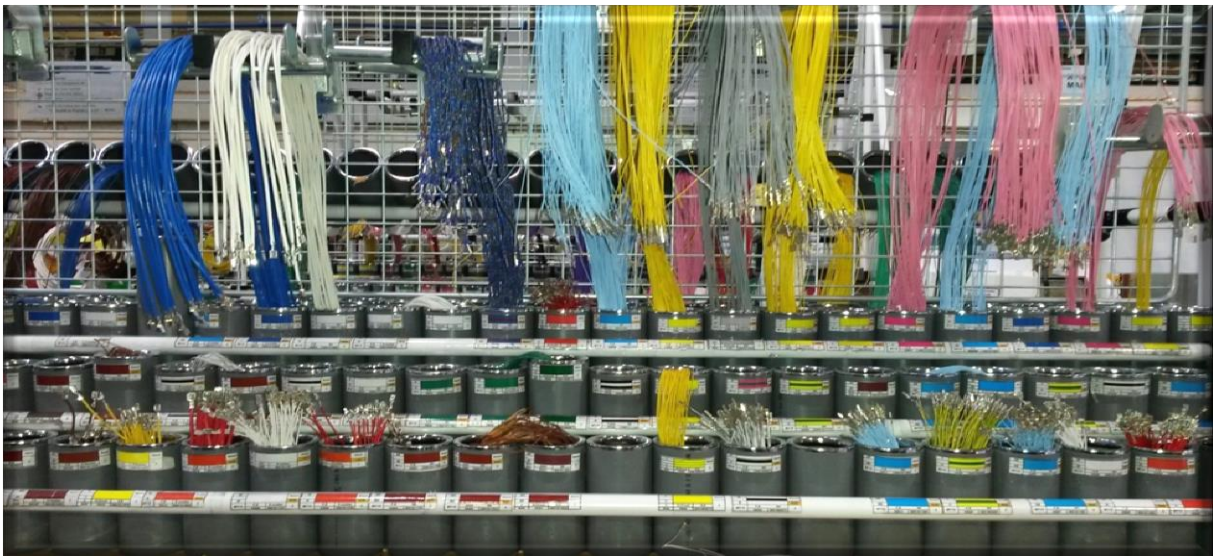
Figure 52: Structure existante au projet NISSAN
