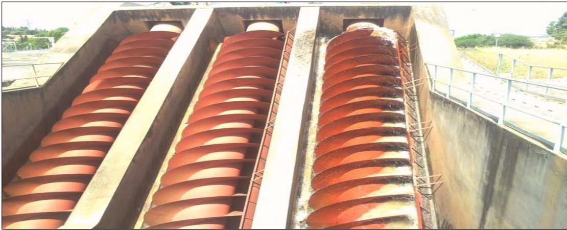
figure2 : les Vis d' A Archimède .
