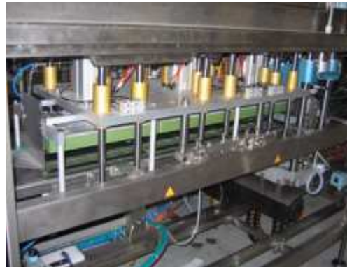
Figure 9 : Boîte de chauffe
