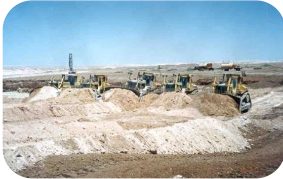
Figure 6 : Décapage par bulldozers
