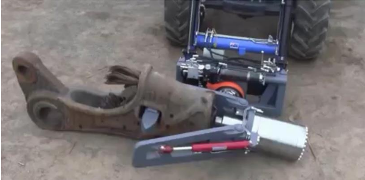
Figure 60: Nouvelle méthode d'extraction de cœur de la chape
