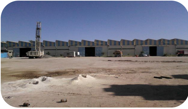
Figure 14 : Atelier dragline et sondeuse de l'extérieur
