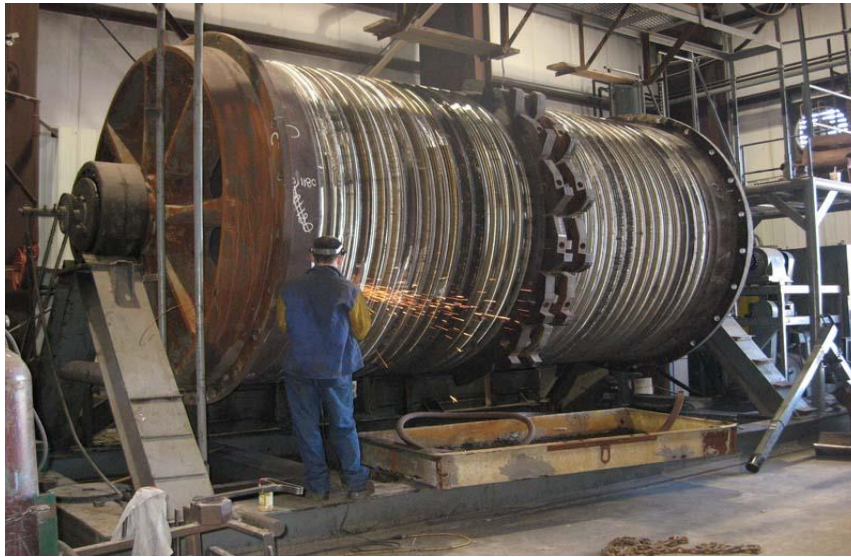
Figure 52: Réparation des treuils
