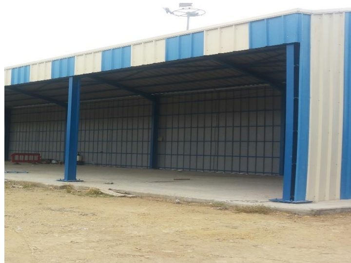
Figure 53 : Bâtiment de stockage
