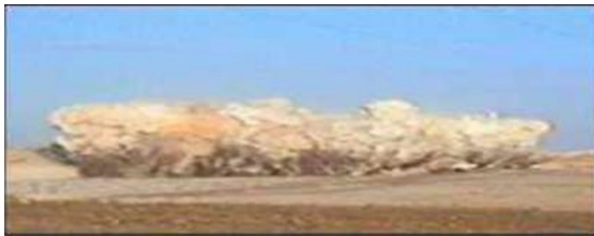
Figure3-opération du sautage par des explosifs
