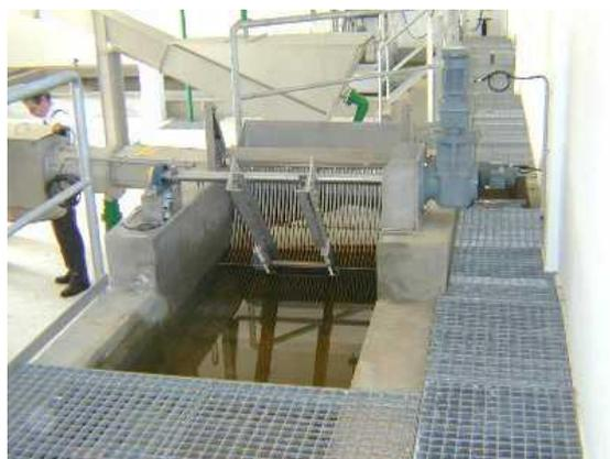
**Figure 2: Dégrilleur automatique**
