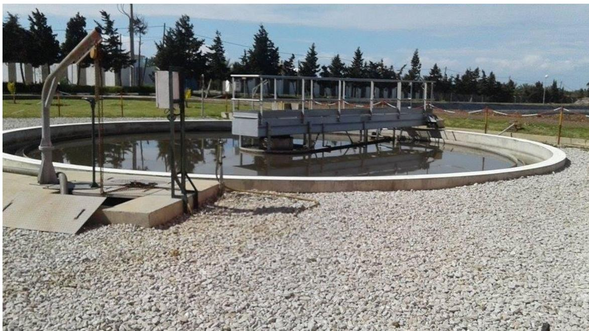
**Figure 5: Décanteur primaire de la STEP**
