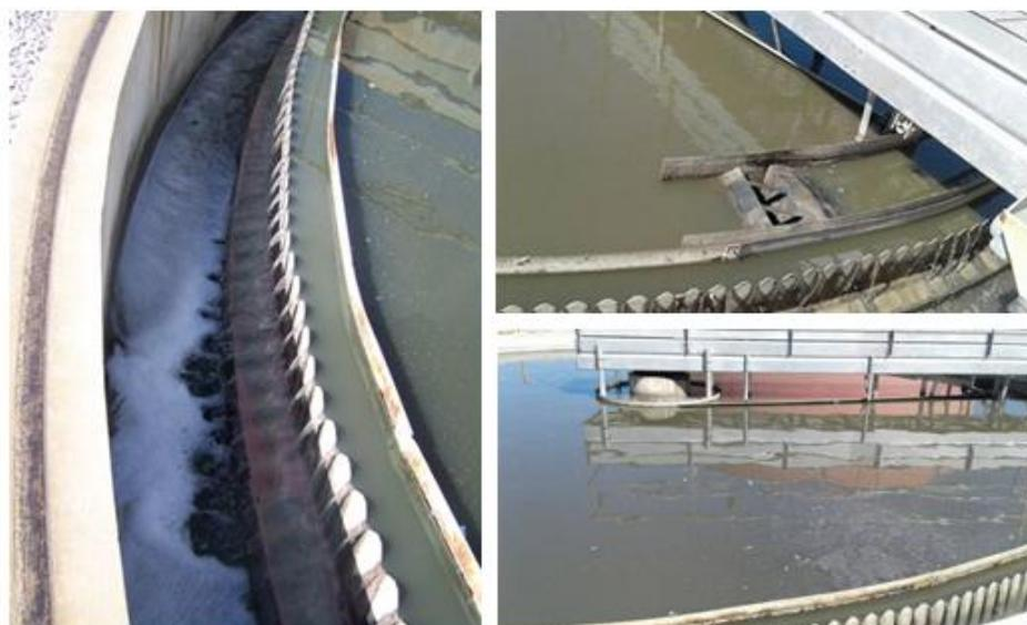
**Figure 6: Gouttière qui entoure le décanteur**
