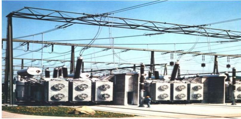
**Figure N°12 : Transformateurs de puissance dans un poste ouvert.**
