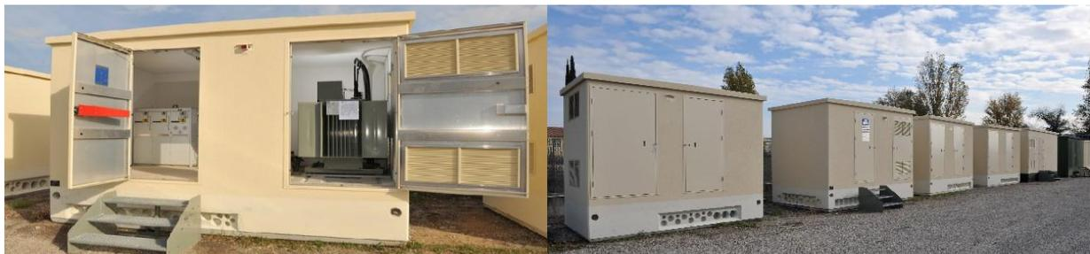
Figure N°10 : Exemple d'un poste préfabriqué.
