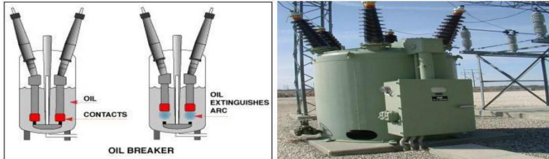
**Figure N°13 : Disjoncteur à coupure dans l'huile.**
