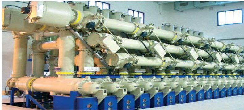
Figure N°9 : Une partie d'un poste isolé en SF<sub>6</sub>.
