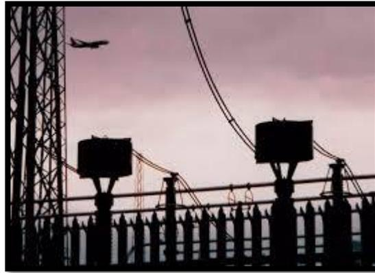
Figure 12:circuit bouchon
