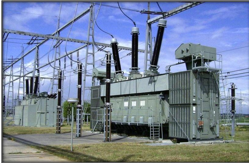
Figure 14: Transformateur de puissance
