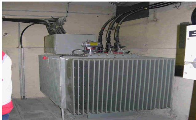
Notre transformateur est de type abaisseur de tension, il transforme 22 000 v à 380 v avec une puissance de sortie 630 KVA. Son couplage est de type **DYN11**, ce qui signifie que le primaire est couplé en triangle (**D**) et le secondaire en étoile (**Y**), Désigne le neutre de sortie **et11** présente l'indice horaire qui est déphasage entre la tension (BT) et la tension (HT) d'une même colonne.
