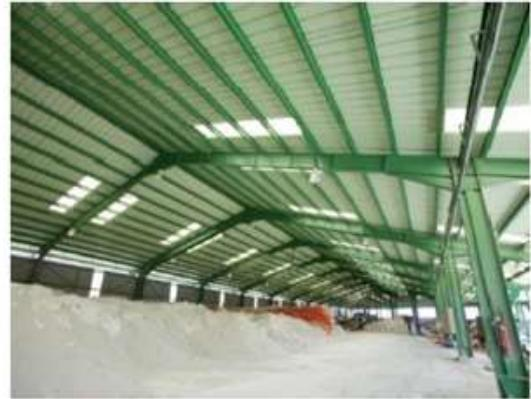
Figure 4: Réalisation en charpente pour le stockage des engrais (client OCP)
