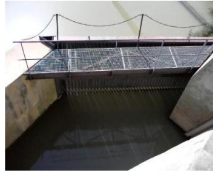
Figure 3 : le dégrilleur
