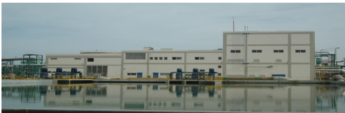
Figure 11: Vue d'ensemble de la centrale thermique
