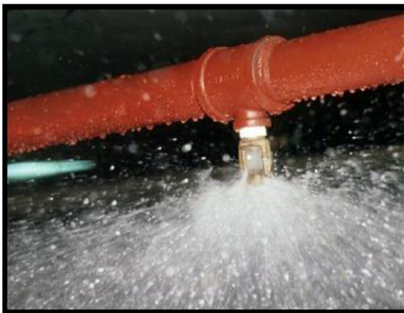
Figure 26: Sprinkler déclenché
