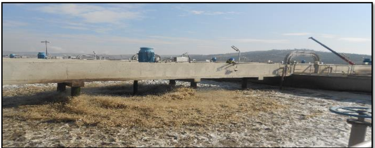
Figure 1.5 : Photos du bassin d'aération
