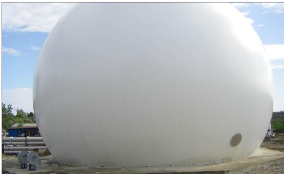
Figure 3: Digestion des boues
