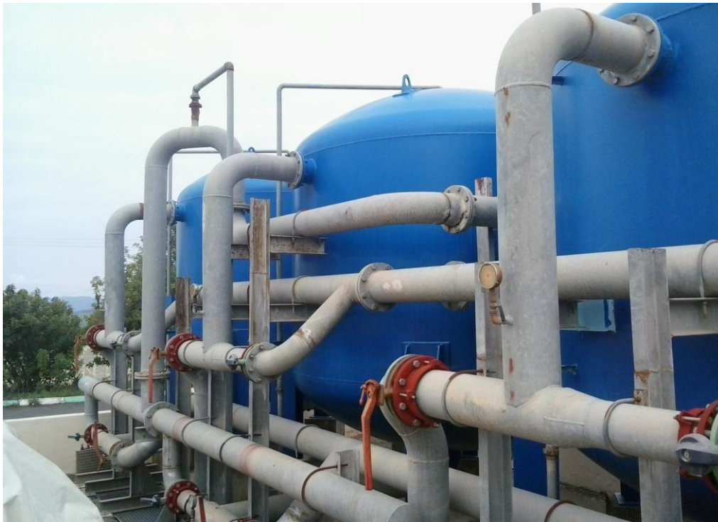
Figure 6: pompes des filtres à charbon actif
