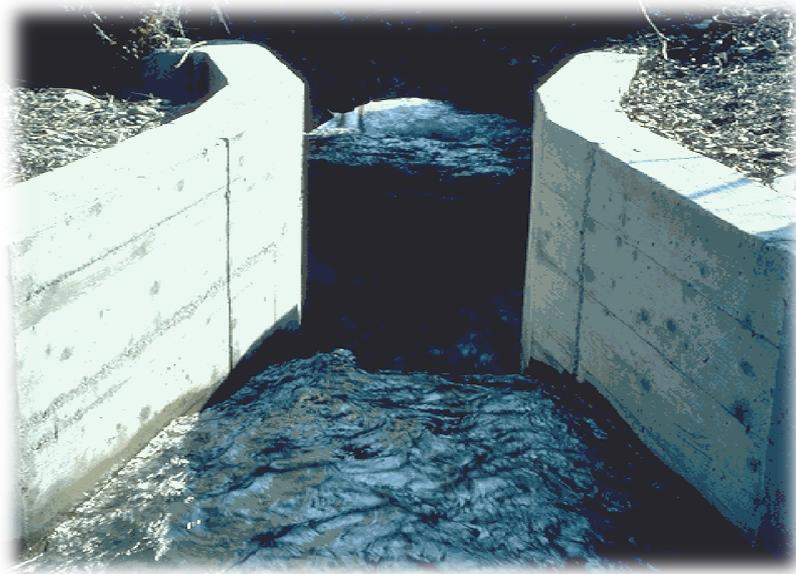
Figure 23 : photo d'un canal calibré pour augmenter la précision des mesures
