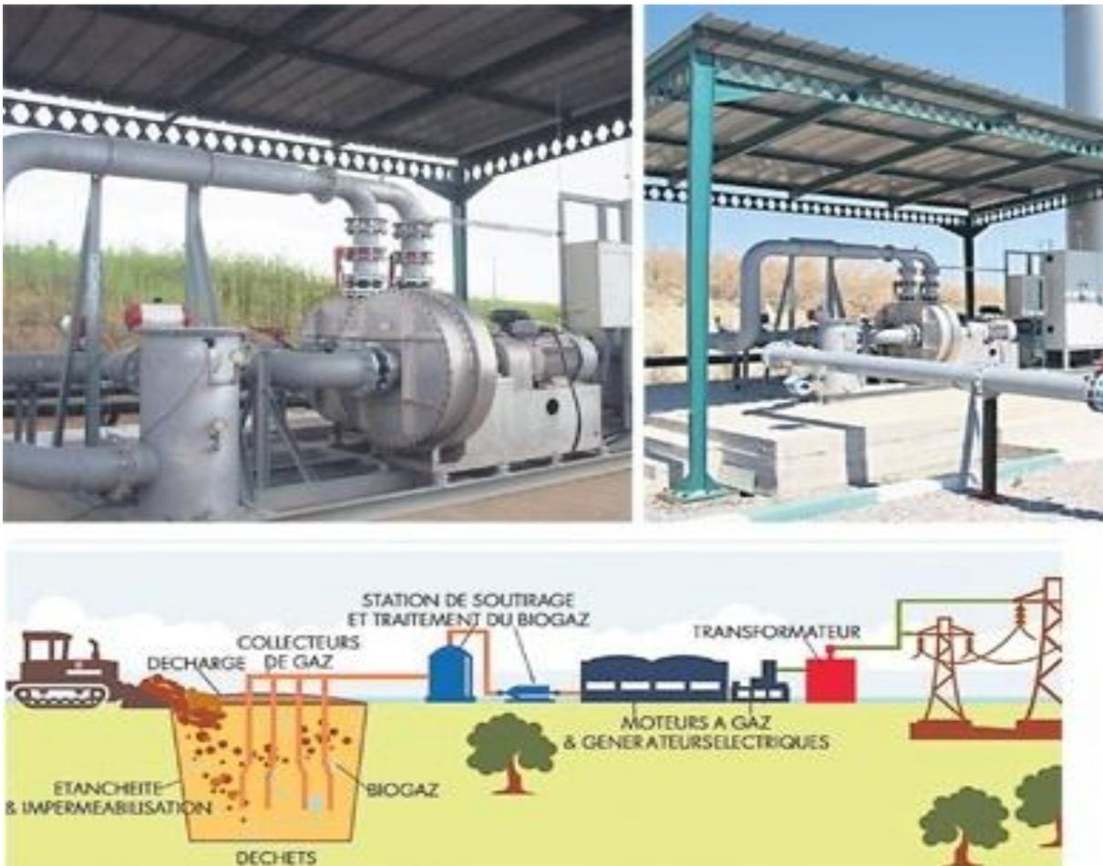
*Figure 13 : Centrale Electrique de la production du Biogaz ECOMED FES*
