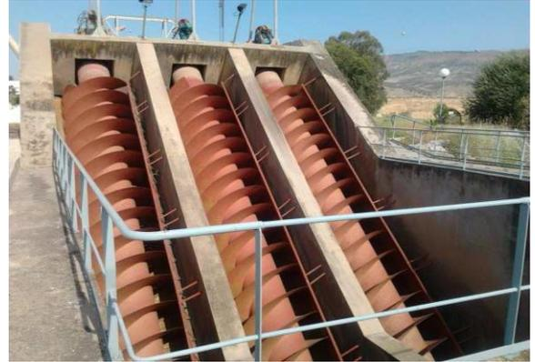
Figure 4 : les vis d'archimide
