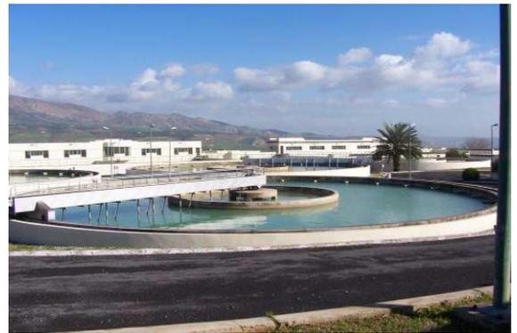
**Figure 10 : décanteur**
