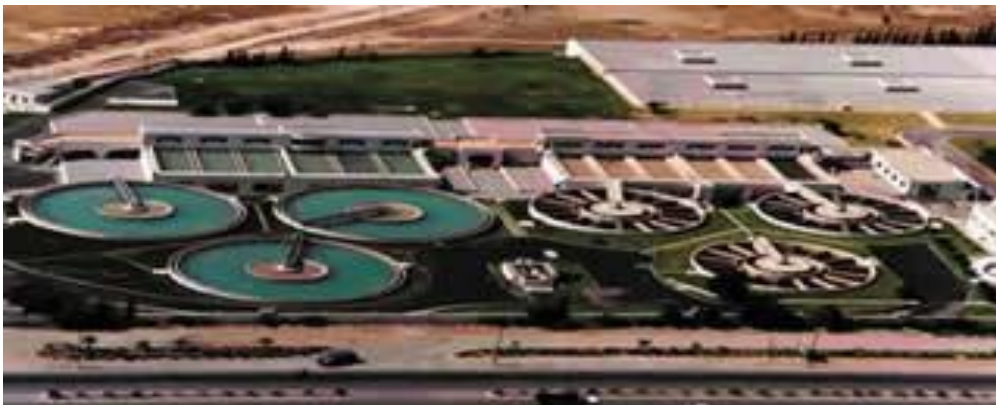
Figure1 : Station de traitement des eaux d'oued Sebou/Fès
