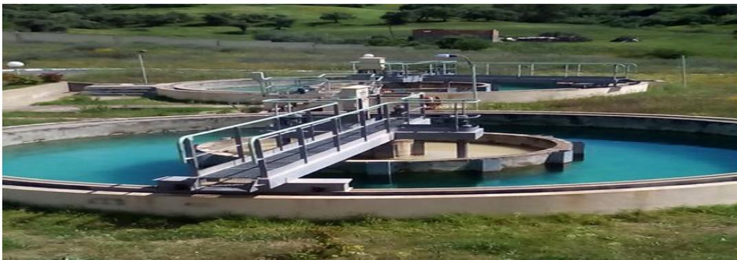
Figure 3: Décanteur
