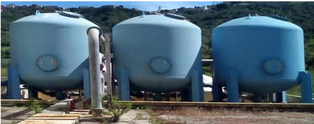
Figure 4: Filtre à charbon actif en grain
